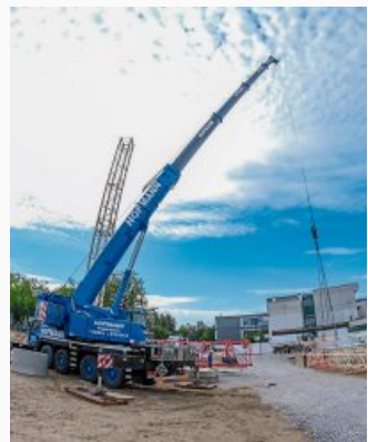
Der 13 Meter hohe Kran wird gerade aufgebaut.
