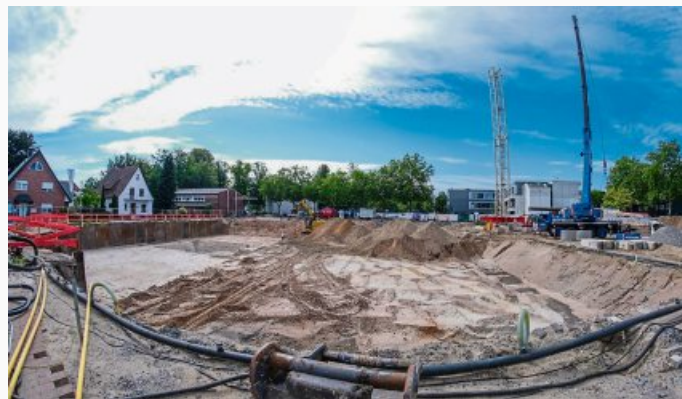
Die rund fünf Meter tiefe Baugrube für das Hallenbad ist bereits ausgehoben. Bald beginnt das Gebäude zu wachsen.
